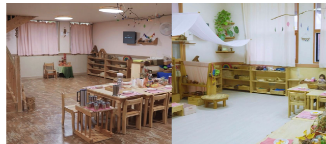
幼儿园地板材料施工前后
